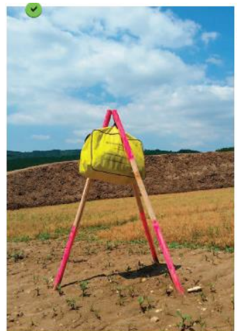
Figure 14 : Exemple d'un kit anti-pollution isolé du sol (Source : Guide des bonnes pratiques environnementales -Protection des milieux aquatiques, AFB 2018)
